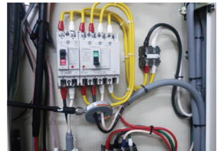
電流プローブでのノイズ確認
