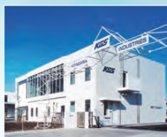
稲沢工場 Inazawa factory
