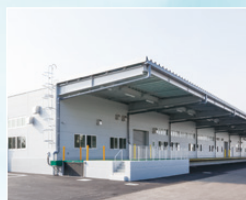
春日井工場 Kasugai factory
